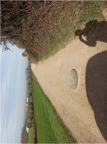
Figura 21. Traça de la canonada al PK 1+700 i arqueta ventosa. Vista en el sentit contrari de la traça
